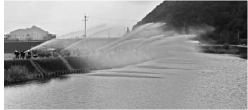
伊与木川堤防で行われた一斉放水
