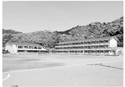
完成した佐賀中学校新校舎と体育館
