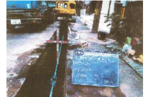
耐震管に布設替
