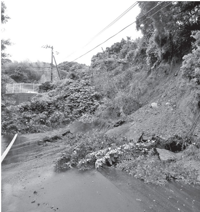
豪雨により土砂崩れした町道王無線（上川口）
