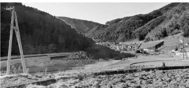
片坂バイパス市野瀬工事用道路
