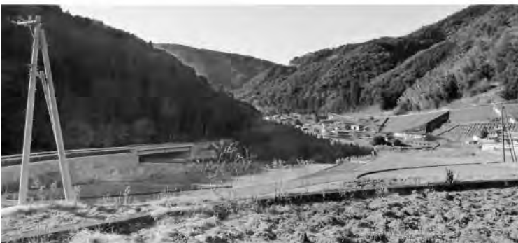
片坂バイパス市野瀬工事用道路
