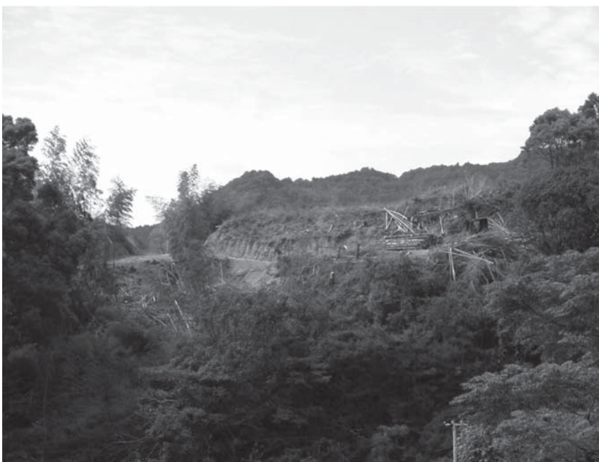
新庁舎造成予定地工事始まる
