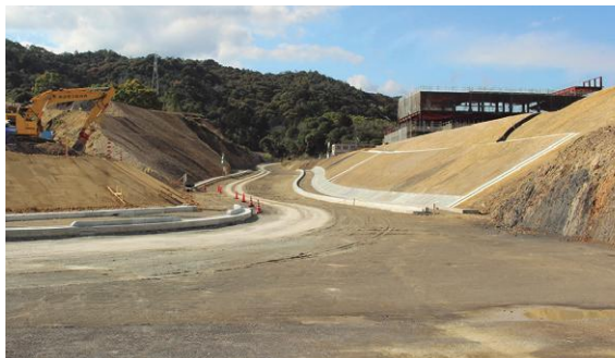
町道新庁舎防災広場線工事の現況（4月2日）
