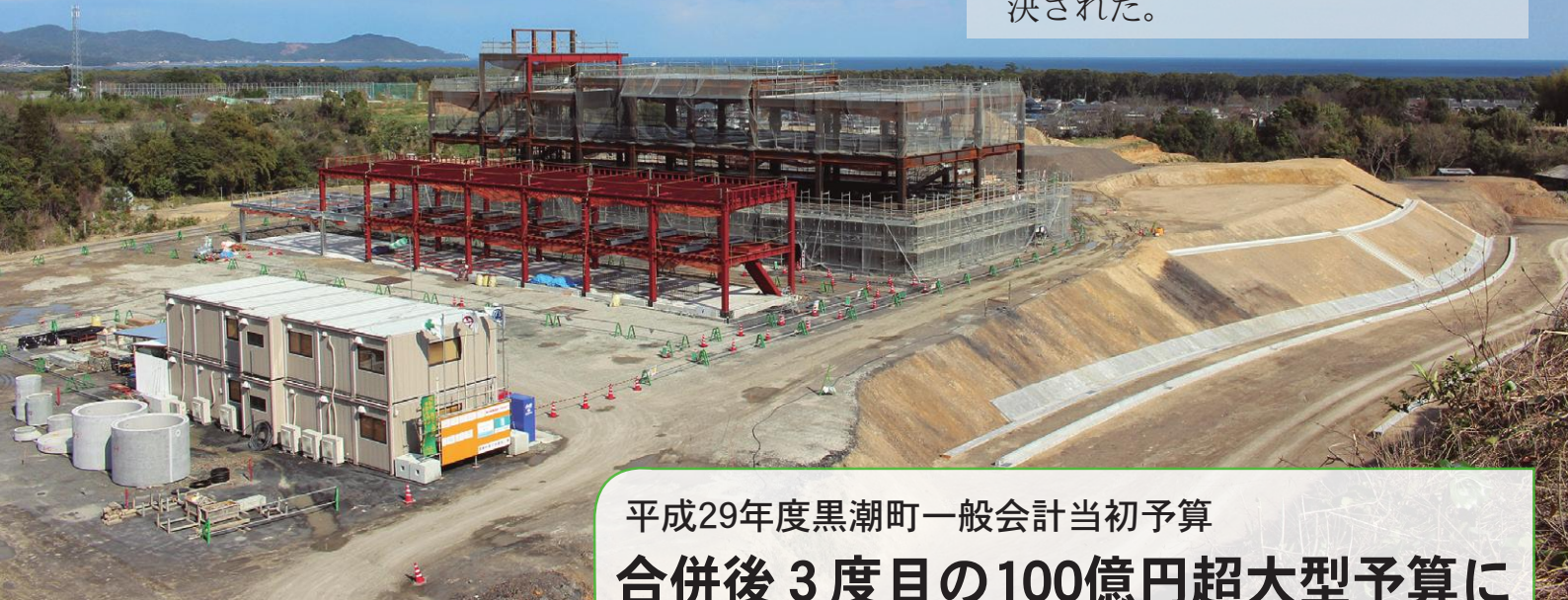
新庁舎建設工事の現況（4月2日）
