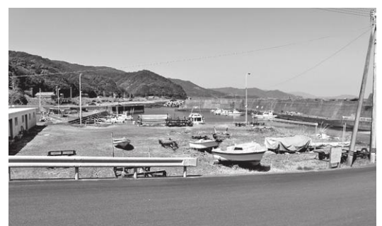
堤防の延命措置を図る灘漁港
