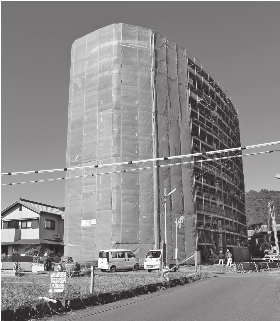
安全第一で工事の進む佐賀避難タワー（2月中旬）
