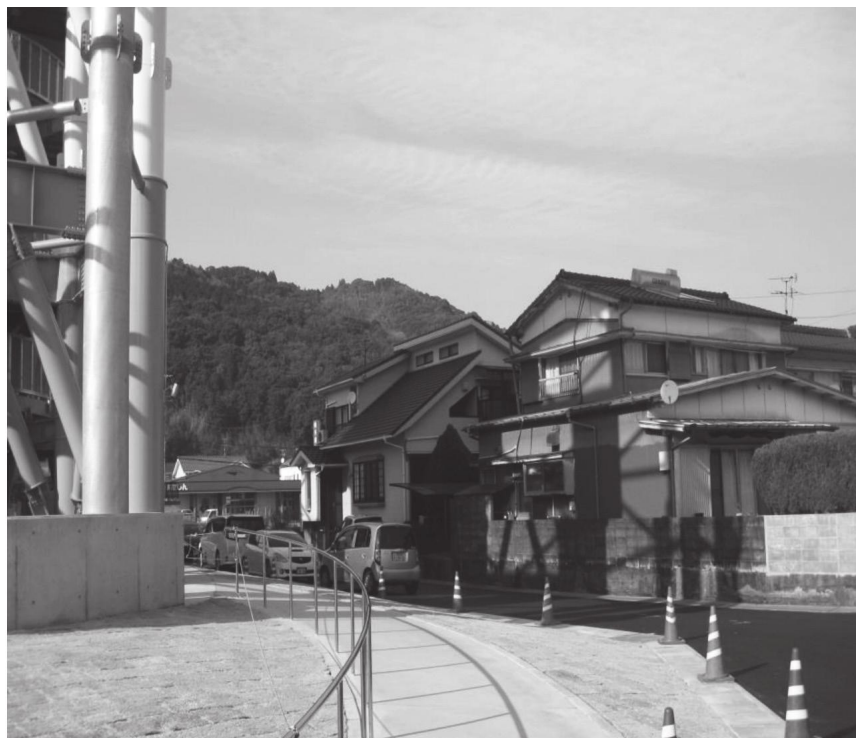
佐賀地区津波避難タワー周辺(午後2時過ぎ頃)
